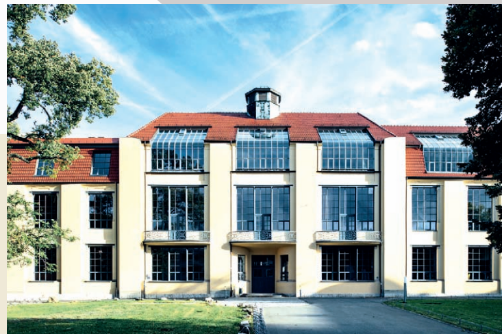
Das Hauptgebäude der ehemaligen Kunstschule in Weimar
